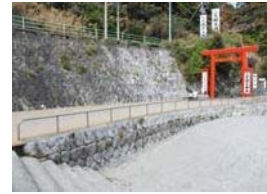
〈28〉ガードパイプ 1
